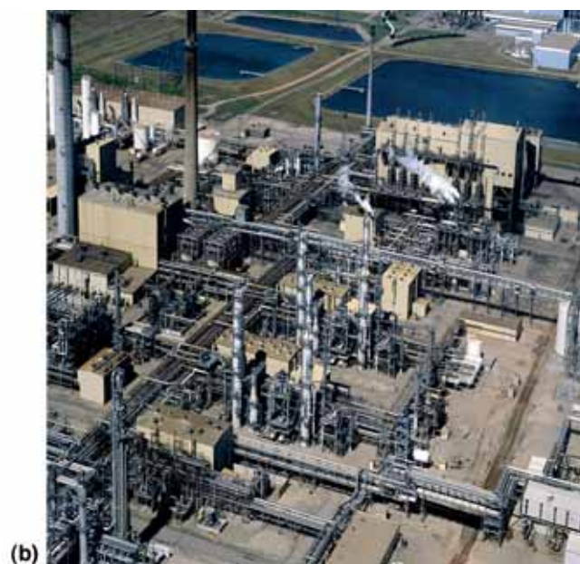
Рисунок ТР.4. (a) Улавливание CO 2 после сжигания топлива на установке в Малайзии. В этой установке применяется процесс химической абсорбции для отделения 0,2 МтCO 2 в год от потока дымового газа энергоустановки для производства мочевины, работающей на сжигании газа (с разрешения «Мицубиши хэви индастриз»); (b) улавливание CO 2 до сжигания на установке газификации угля в Северной Дакоте, США. В этой установке применяется процесс на основе физического растворителя для отделения 3,3 МтCO 2 в год из газового потока для производства синтетического природного газа. Часть захваченного CO 2 используется для проекта ПИН в Канаде.
