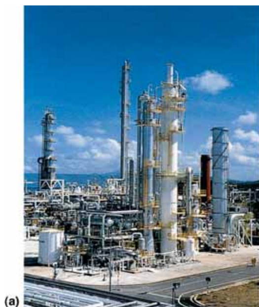
Рисунок ТР.4. (a) Улавливание CO 2 после сжигания топлива на установке в Малайзии. В этой установке применяется процесс химической абсорбции для отделения 0,2 МтCO 2 в год от потока дымового газа энергоустановки для производства мочевины, работающей на сжигании газа (с разрешения «Мицубиши хэви индастриз»); (b) улавливание CO 2 до сжигания на установке газификации угля в Северной Дакоте, США. В этой установке применяется процесс на основе физического растворителя для отделения 3,3 МтCO 2 в год из газового потока для производства синтетического природного газа. Часть захваченного CO 2 используется для проекта ПИН в Канаде.
